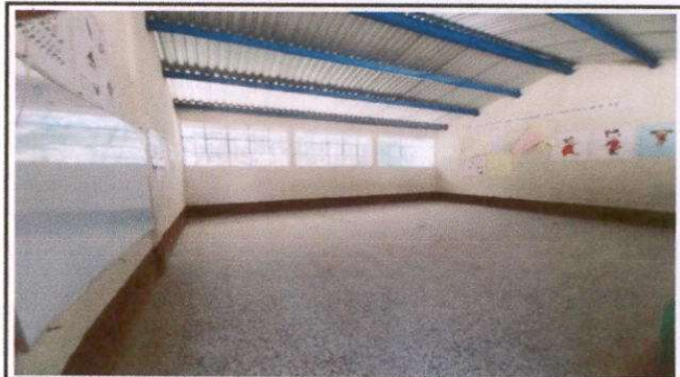
Foto 4: Sustitución de piso concreto por piso granito ( aula 3)
