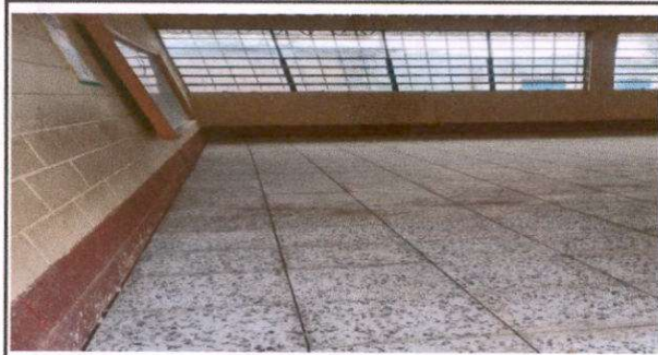
Foto 3: Sustitución de piso de concreto por piso de granito (aula 2)
