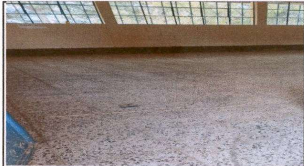
Foto 2: Sustitución de piso de concreto por piso granito (aula 1)
